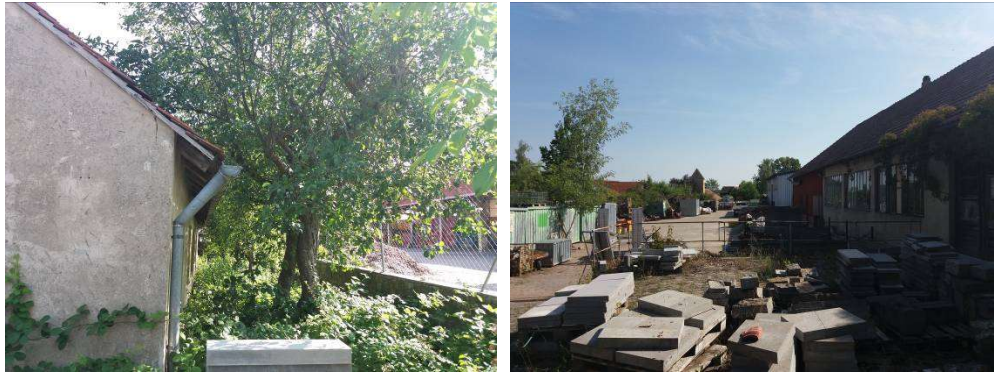
Abb. 3 und 4: Ausschnitte aus dem Sanierungsgebiet (Zentrum)
