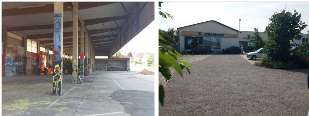
Abb. 5 und 6: Ausschnitte aus dem Sanierungsgebiet (Ost und West)
